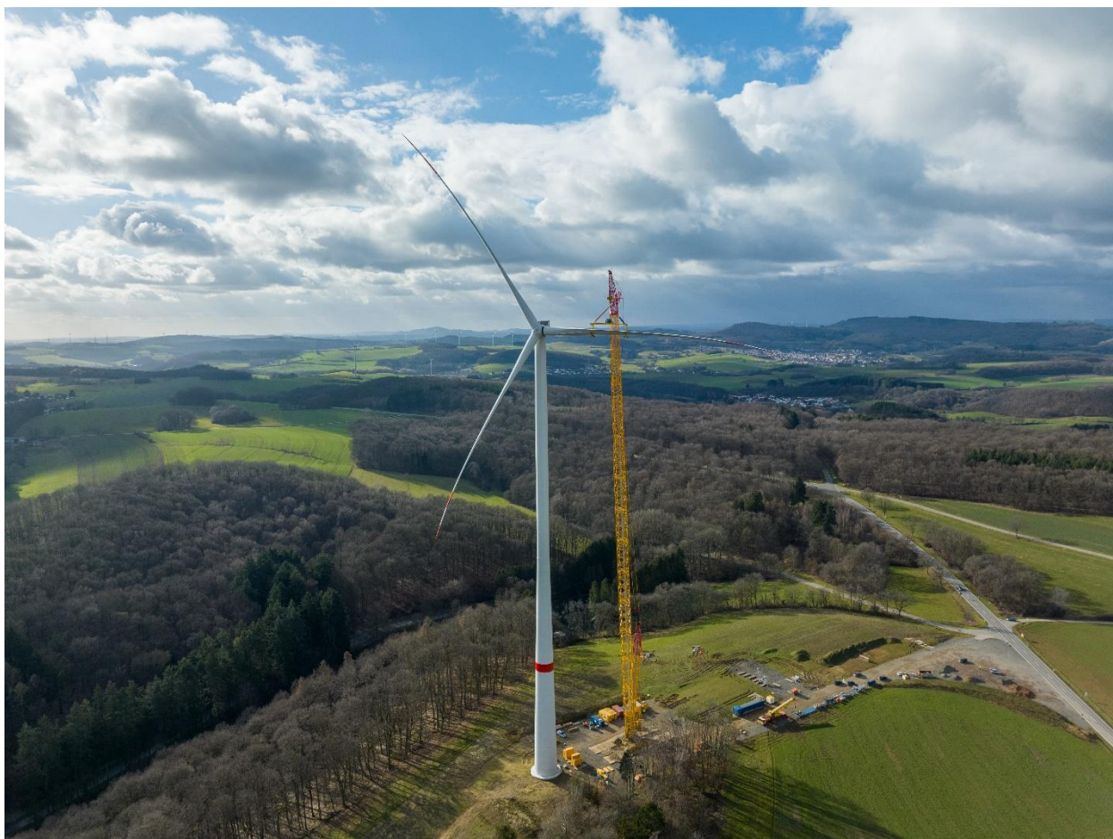
Montage der Rotorblätter im Prokon-Windpark Langenbach (Foto: © Sven Grajek)
